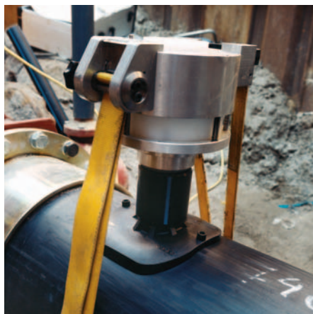
Прижимное приспособление FRIATOP прижимает усилием, создаваемым в его пневматической камере, детали седлообразной формы к трубе из полиэтилена перед сваркой.
