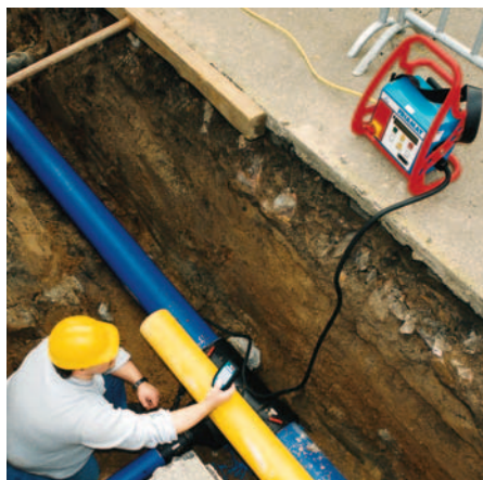
Сварочный аппарат FRIMAT® с инфракрасным пультом дистанционного управления
