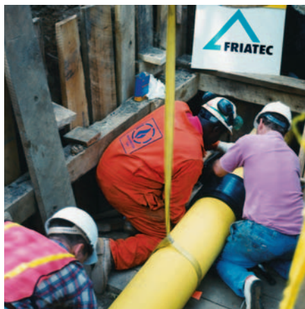
Монтаж при помощи большой муфты FRIALEN® соединения вставки с концом газовой трубы после протяжки ее в металлической трубе (метод Relining), имеющей первоначально U-образную форму и затем выровненную, г. Вашингтон.
