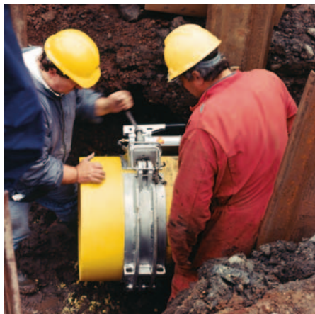
Гидравлическое приспособление для устранения овальности устраняет овальность труб из ПЭ в пределах \pm 3\% , обусловленную складированием. Применяется для труб диаметром от 280 до 710 мм.
