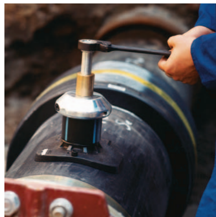
Приспособление для врезки FRIALEN® позволяет врезаться через детали FRIALEN® в безнапорные или находящиеся под рабочим давлением трубы из полиэтилена.
