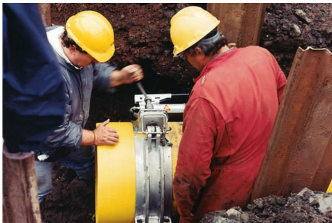
Гидравлическая скругляющая накладка устраняет овальность до \pm 3\% у ПЭ-труб, вызванную условиями складского хранения. Применяется для диаметров от d 280 до 900 мм.
