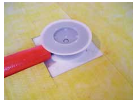
9. Уложить на плиту звукоизоляционные плиты
