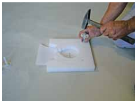
4. Прикрепить с помощью дюбелей нижнюю часть комплекта
