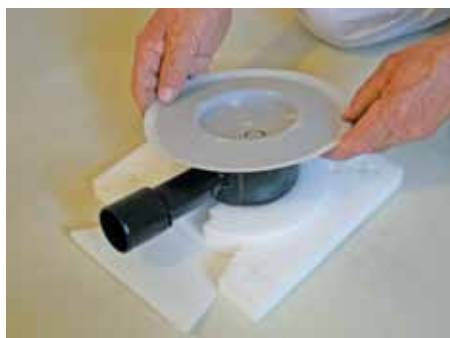
7. Установить корпус трапа с монтажной заглушкой
