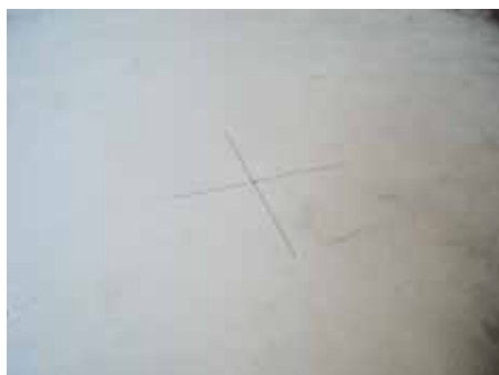
1. Отметить на плите расположение трапа
