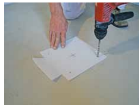
3. Просверлить в плите отверстия для монтажа звукоизолирующего комплекта
