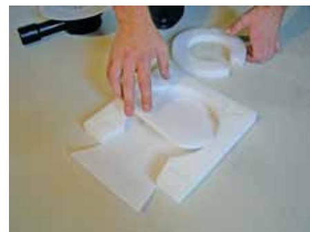
6. При необходимости увеличить высоту установки трапа
