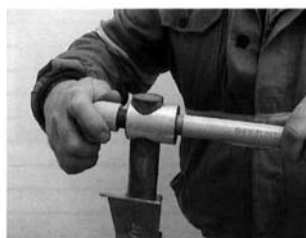
рис. 37: Внутреннюю поверхность фасонины и наружную поверхность конца трубы нагреем до температуры сварки таким образом, что на стержень наденем фасонный элемент, а в стержень вставим обозначенный конец трубы. Одновременно контролируем, если присоединение и надевание не происходит слишком свободно.
